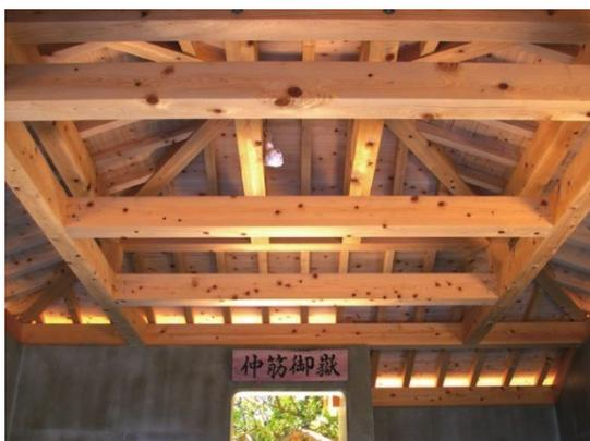
在来仕口と金物を組み合わせた構法で、無垢材にも適合するため、強度を保ちながら日本の伝統的な木造建築の象徴である木組みの美しさを現代建築において表現できる。
